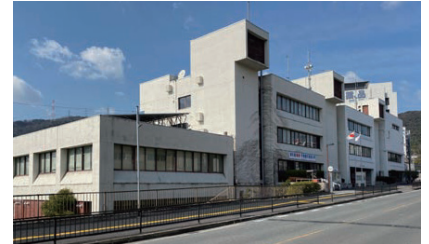
設置後49年が経過した役場庁舎
