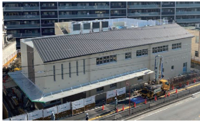
現在、建設中の第四保育所
